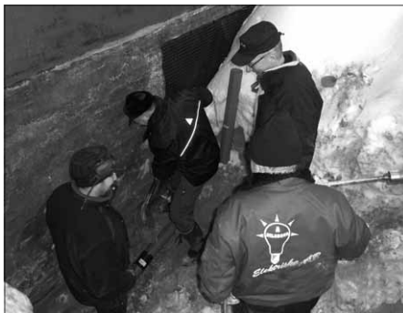
Andreas, Börje och Sune kontrollerar att Lennart rätt monterar sista metern av dräneringsrör före igengrävningen. Foto: Lars Brännström
